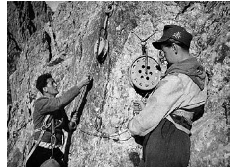
Das System „Stahlseil“ mit der 100-m-Trommel und der Bremsvorrichtung (Bremstrommel)
